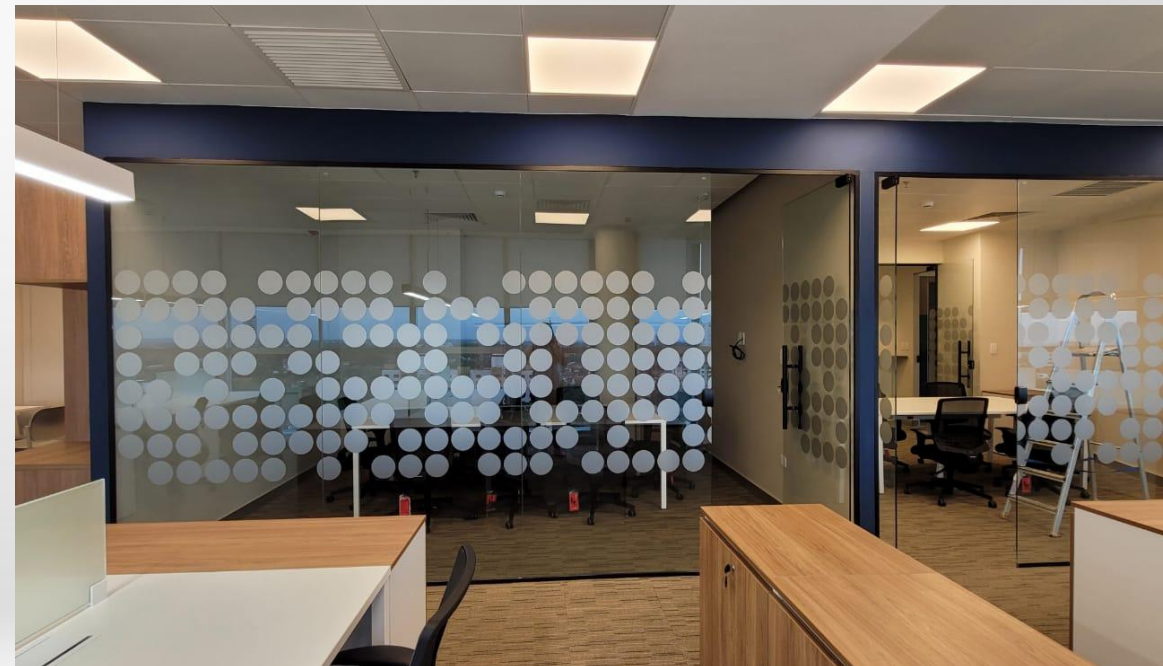
EDIFICIO PARK PLAZA. Instalación de tabiques de durlock, instalación de aberturas de vidrio templado con perfilera de color negro.
