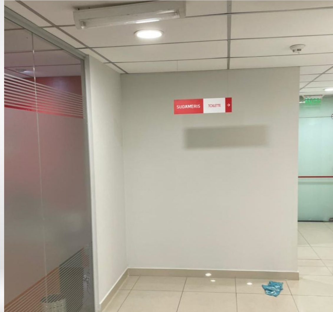
SUDAMERIS BANK - TRABAJOS DE REFACCIÓN, PINTURA Y CIELORRASO.
