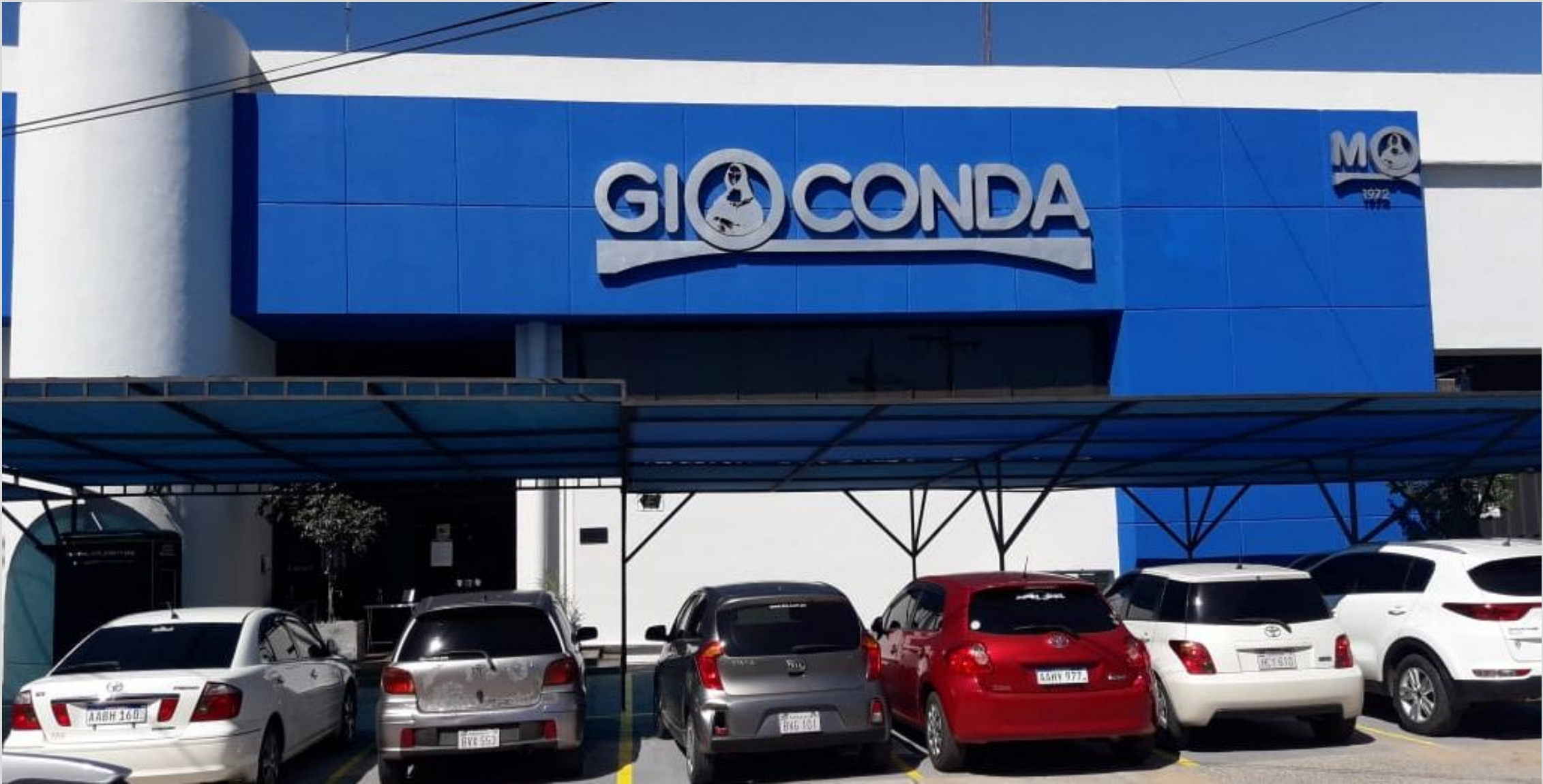
LA GIOCONDA - TRABAJOS DE REFACCIÓN Y PINTURA EXTERIORES.
