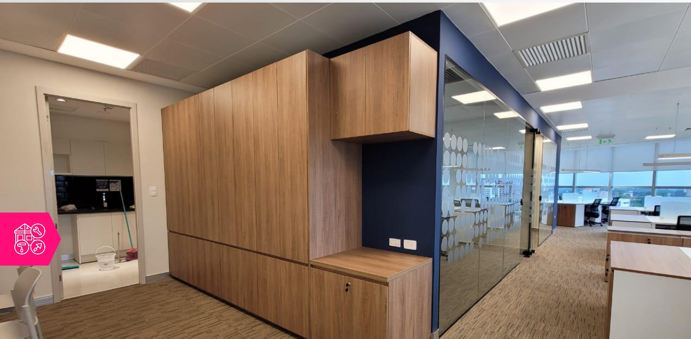
EDIFICIO PARK PLAZA. Instalación de tabiques de durlock, instalación de aberturas de vidrio templado con perfilera de color negro.
