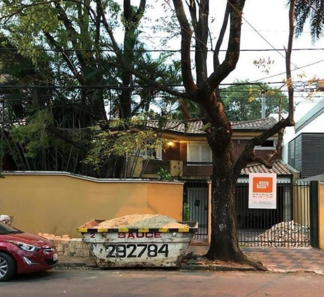
ANTES DEL INICIO DE OBRA...
