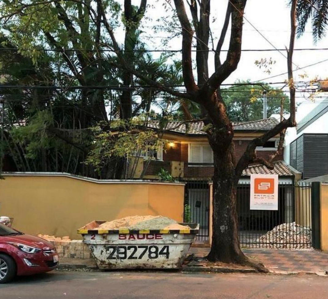
ANTES DEL INICIO DE OBRA...
