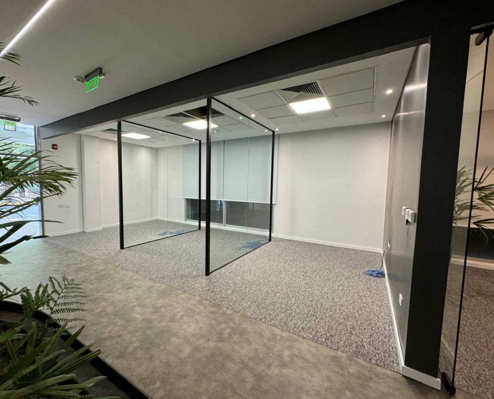
OFICINA CORPORATIVA - EJECUCIÓN DE PROYECTO DE ARQUITECTURA.
