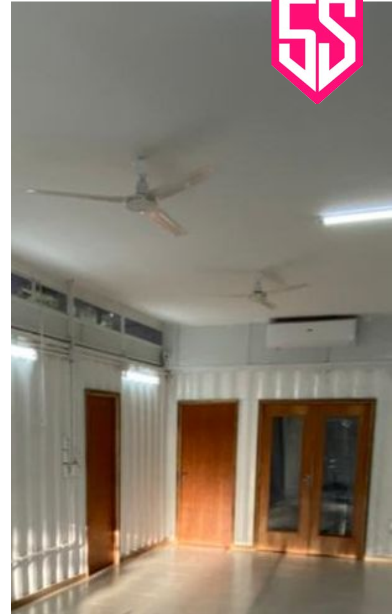
CONSTRUCCIÓN LLAVE EN MANO DE OFICINAS TIPO CONTENEDORES PARA EL MINISTERIO DE SALUD EN SAN JUAN NEPONUCENO.
