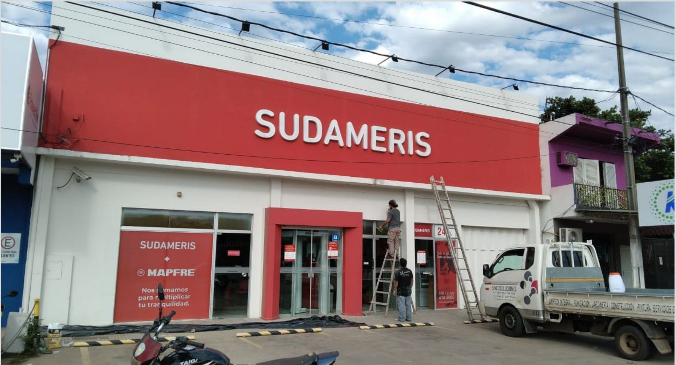
SUDAMERIS BANK - TRABAJOS DE REFACCIÓN, PINTURA Y CIELORRASO.
